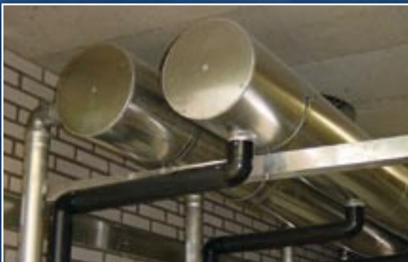
Cascade-opstelling rookgasafvoer en luchttoevoer
